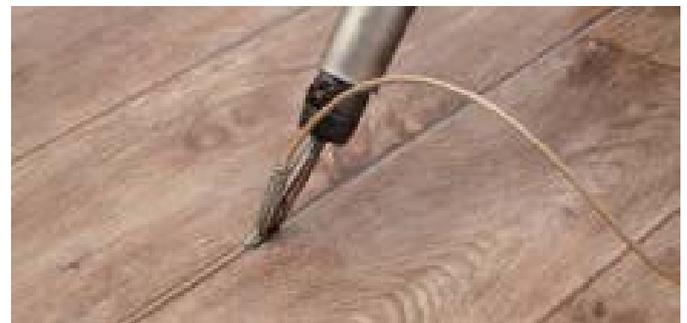
4. Das fachgerechte Abstoßen des Schweißdrahtes in noch warmen Zustand wird unter Verwendung des Mozart-Abstoßmessers und integriertem 0,7 mm-Schweißnahtschlitten (empfohlen) oder dem Viertelmondmesser mit Schweißnahtschlitten bis auf ca. 1 mm Überstand durchgeführt.
