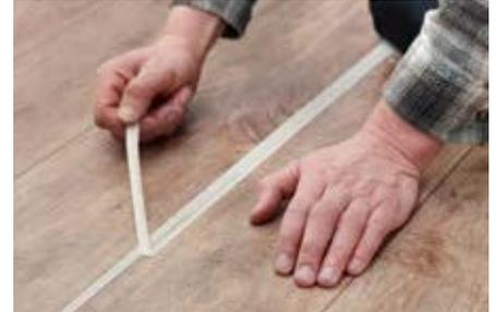
Die Nähte von Eternal können auch thermisch verschweißt werden. Hierbei wird die Naht auf 0,3 mm bis max. 0,5 mm Luft (Scheckkartenstärke) geschnitten. Zum Ausfräsen der Naht ist ein parabelförmiges Fräsblatt mit 3,3 mm Breite zu verwenden. Die Naht wird  $\frac{2}{3}$  tief der Belagsstärke gefräst.
