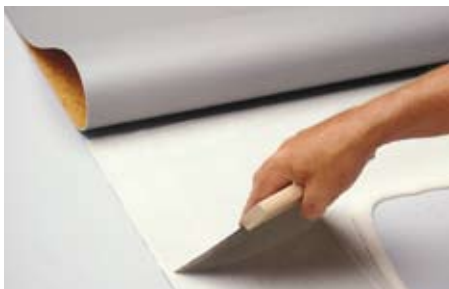
Lijm aanbrengen
