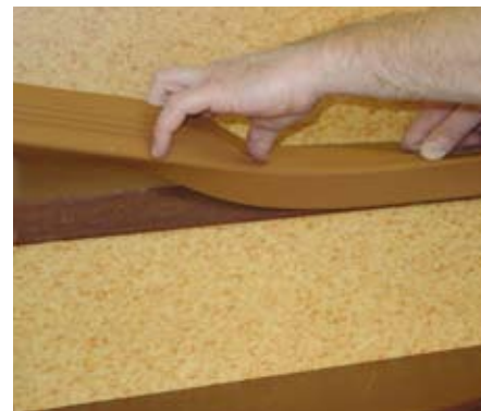
Trapkantprofiel aanbrengen
